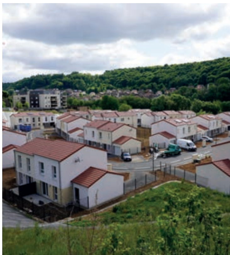
Travaux Clos de la Briquetterie - toute l'année
