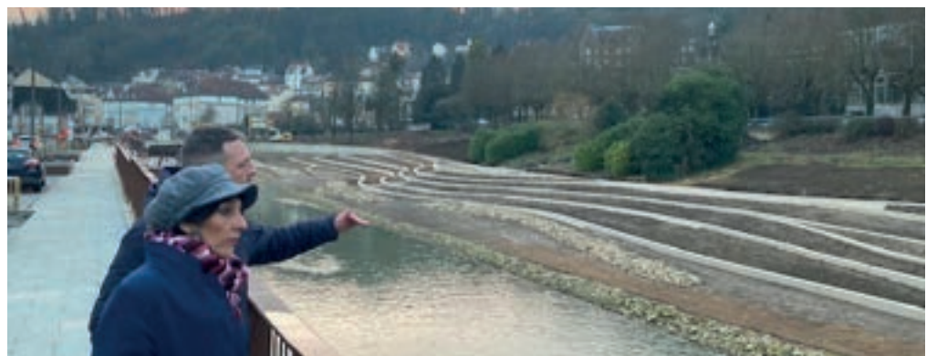
Visite de chantiers par la Présidente du Département - 31 janvier
