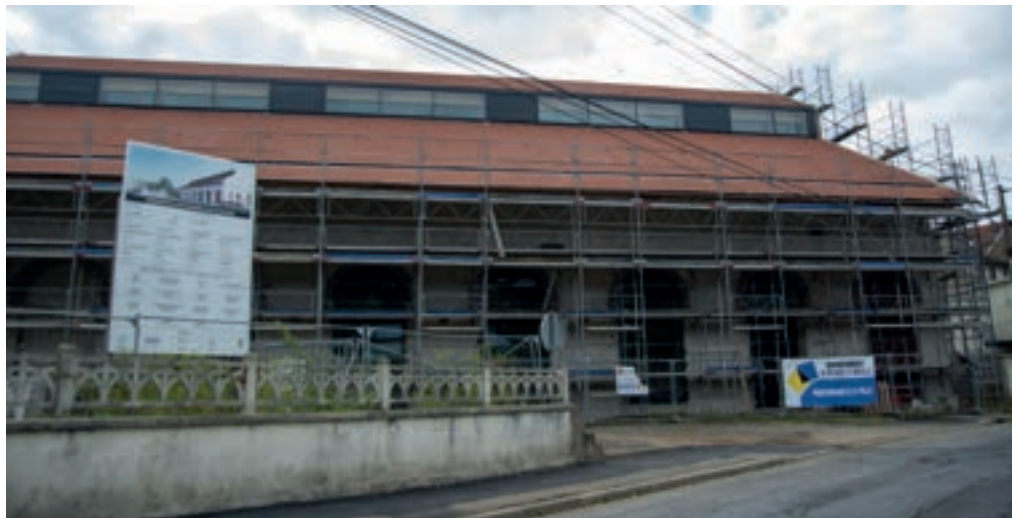
Travaux Halle Saintignon - Toute l'année
