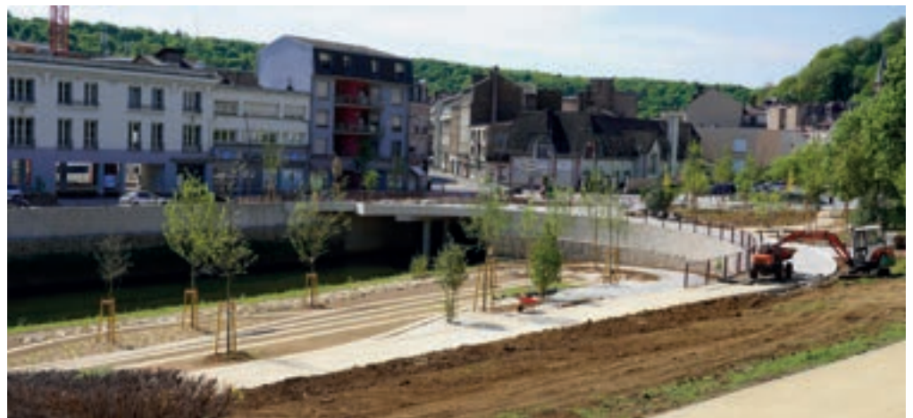
Travaux Parc des Récollets Toute l'année
