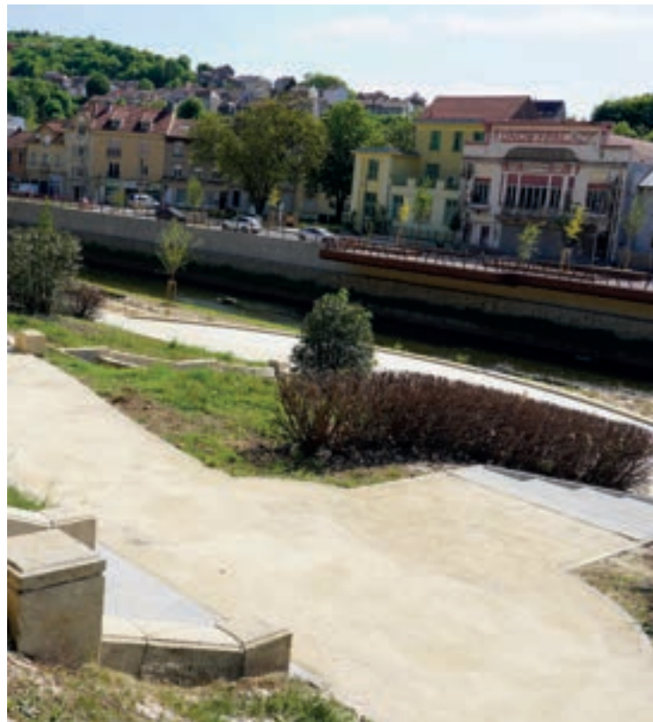
Travaux Parc des Récollets - Toute l'année
